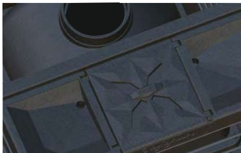
Поворотные заслонки в закрытом положении
